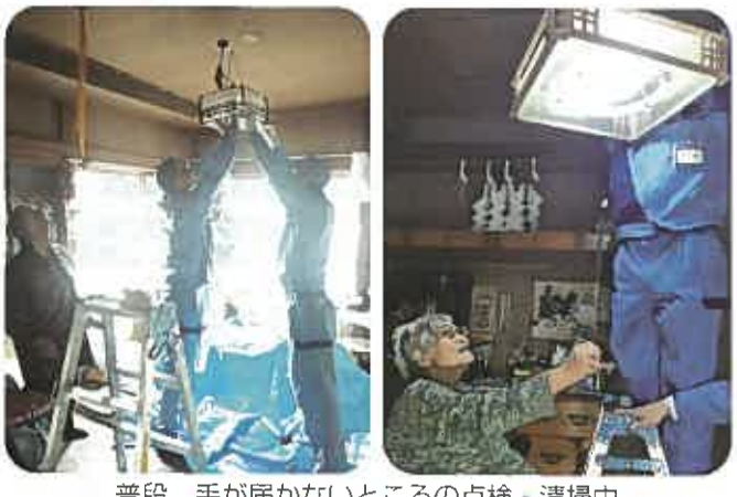
普段、手が届かないところの点検・清掃中
