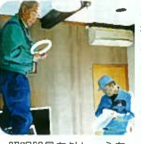
照明器具を外し、心を込めて清掃と点検
