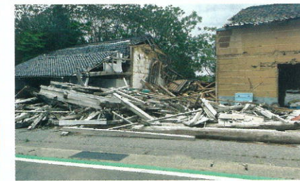
倒壊したまま残る家屋
